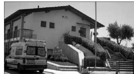
L'edificio che ospita la sede del gruppo Alpini di Grezzana, la Protezione Civile e Croce Verde
